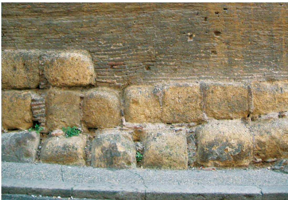
Fig. 68. Fațada nord-estică. Zidăria carolingiană se suprapune peste zidăria din blocuri de piatră din secolul al II-lea.
