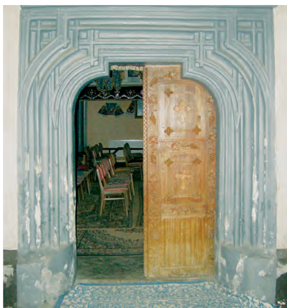
Fig. 134. Chenarul sudic cu baghete încrucișate și tâmplăria recentă.
