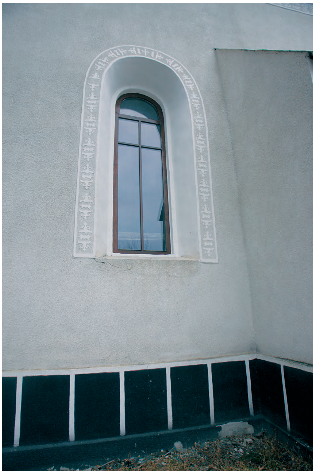
Fig. 115. Finisajele actuale. Tencuiala strop și soclu de mozaic.
