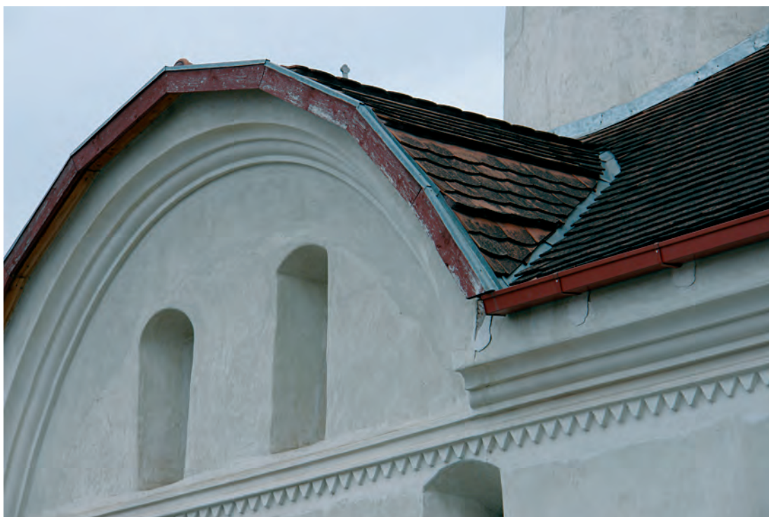
Fig. 185. Hunedoara, detaliu al restaurării recente, timpanul nordic.
