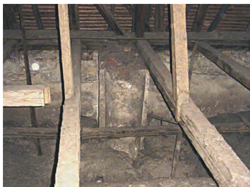
Fig. 93. Pilastrul gotic ce iese deasupra bolții baroce la actuala mănăstire franciscană.
