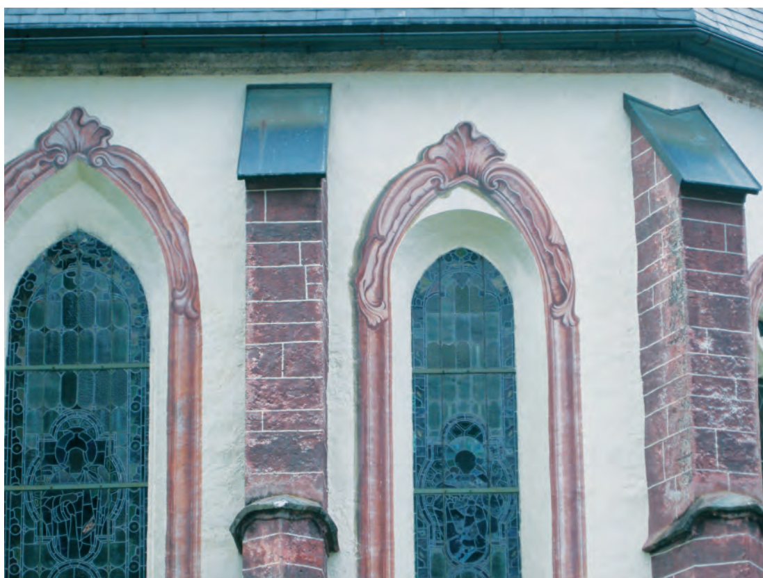
Fig. 84. Kötschach, Detaliu de fațadă.
