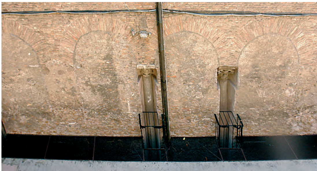
Fig. 76. San Vitale, Coloanele ce despărțeau navele înainte de demolarea colateralelor.
