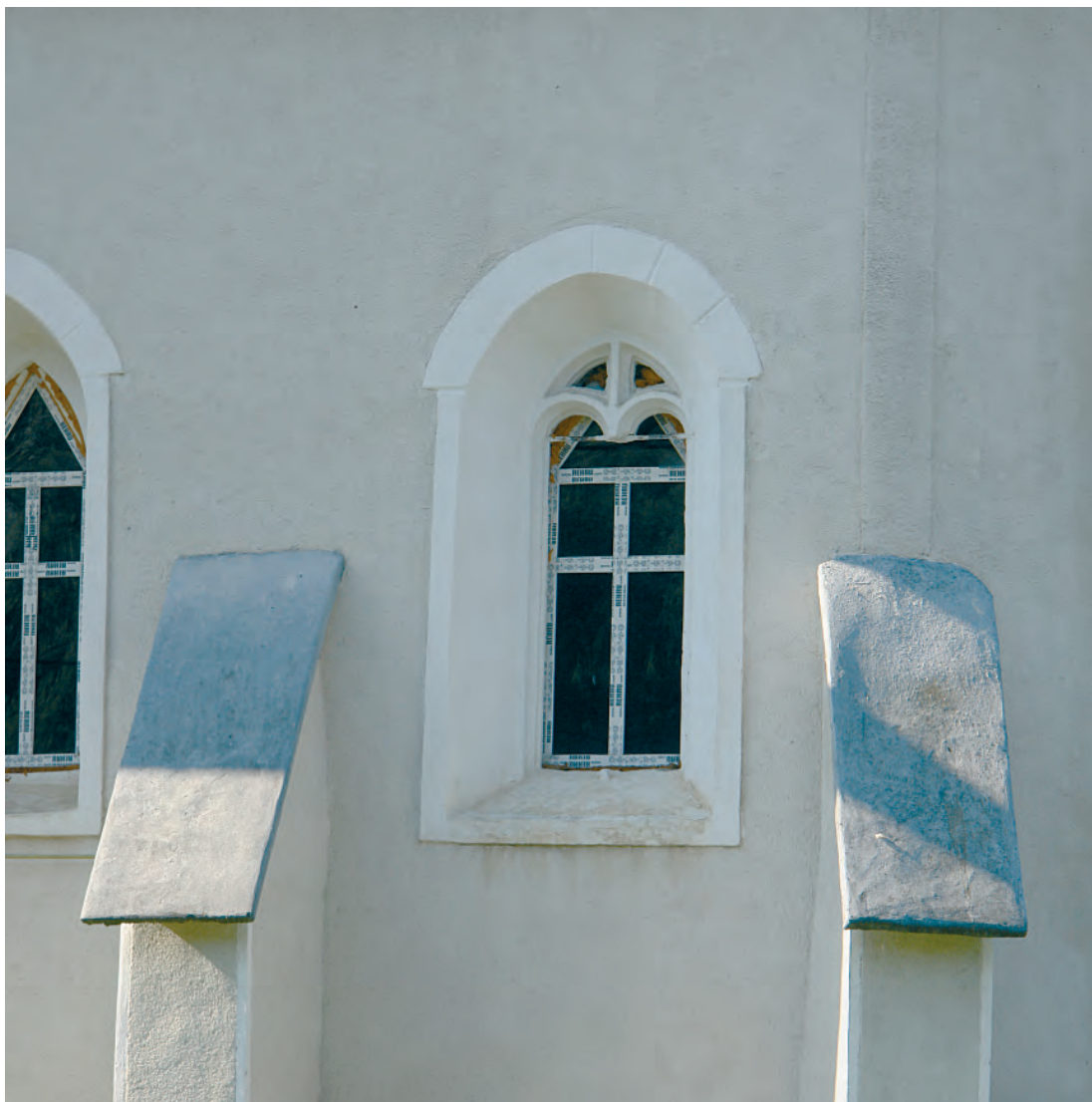
Fig. 154. Arcalia, Biserica ortodoxă, detaliu cor, fereastră cu mulura gotică și tamplarie PVC.
