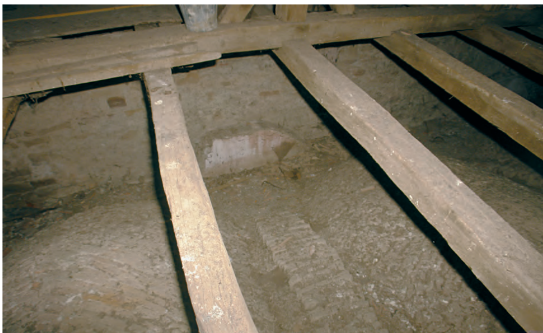
Fig. 175. Șoarș, vedere din pod. Arhivolta gotică este în axul arcului dublou.
