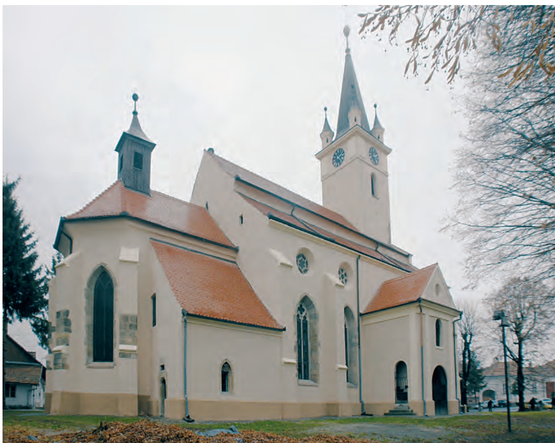
Fig. 188. Reghin, fațada nordică.
