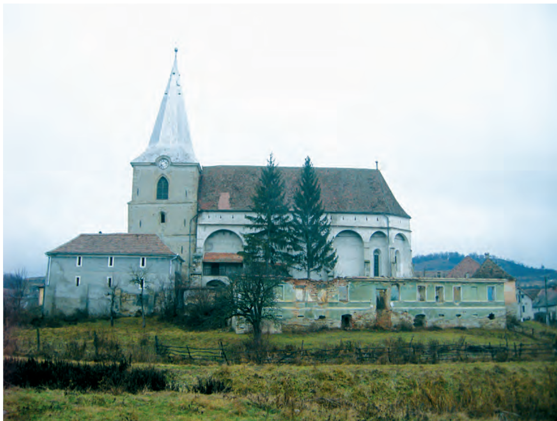
Fig. 171. Șoars, fațada sudică.
