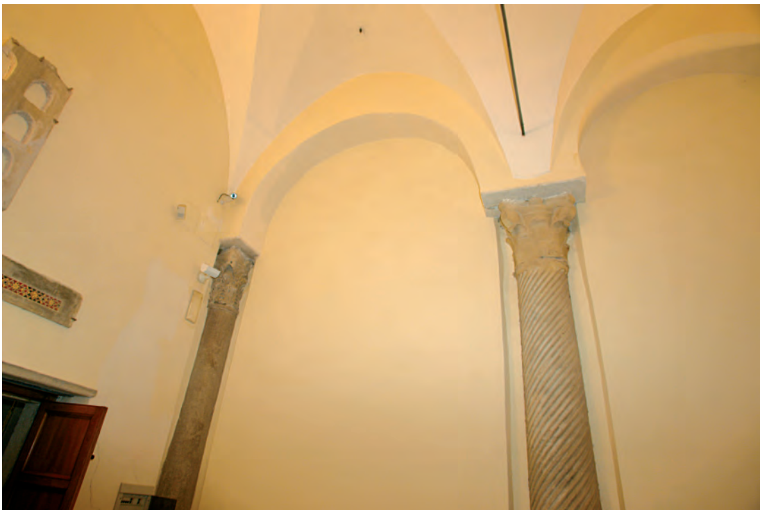
Fig. 64. Santa Cecilia in Trastevere, coloane medievale, acoperite de „restaurarea” barocă, readuse la vedere de restaurarea din secolul XX.
