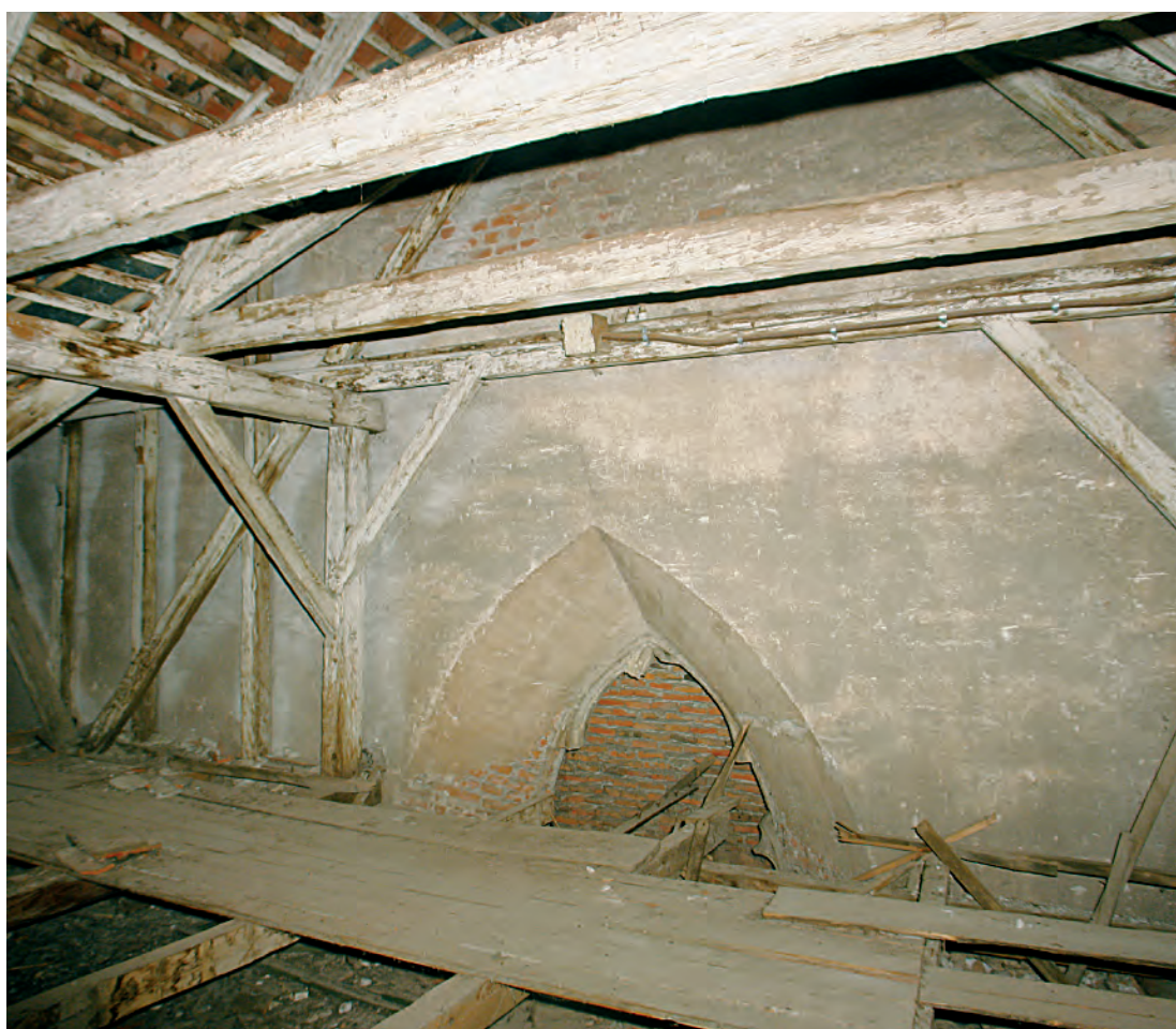
Fig. 100. Sibiu, biserica ursulinelor. Fereastra gotică obturată din fațada sudică, văzută din podul mănăstirii.
