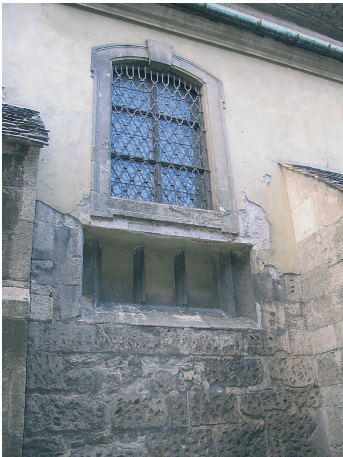
Fig. 91. Buda, Biserica parohiala Nagyboldogasszony. Sub fereastra barocă au fost evidențiate profilele ferestrei anterioare gotice iar piatra fățuită gotică a fost martelată pentru a suporta tencuiala barocă, acum eliminată de restauratori.
