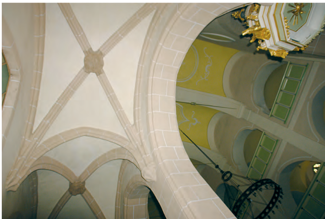
Fig. 192. Reghin, Bolta gotică din nava sudică și boltile baroce din nava centrală și nava nordică.
