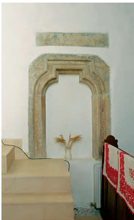
Fig. 142. Chenar gotic către fosta sacristie.
