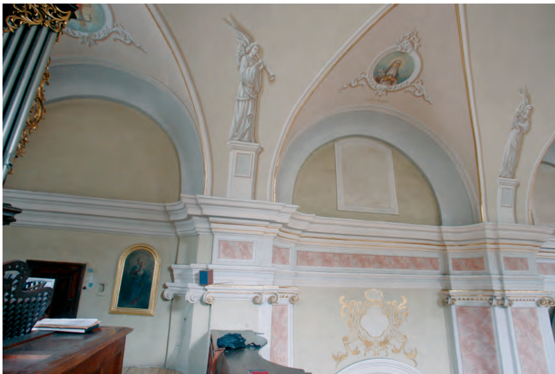
Fig. 95. Pilaștri baroci care îmbracă pilastrul gotic. Peretele dintre pilaștri este în continuare cel gotic, doar vopsit în baroc.
