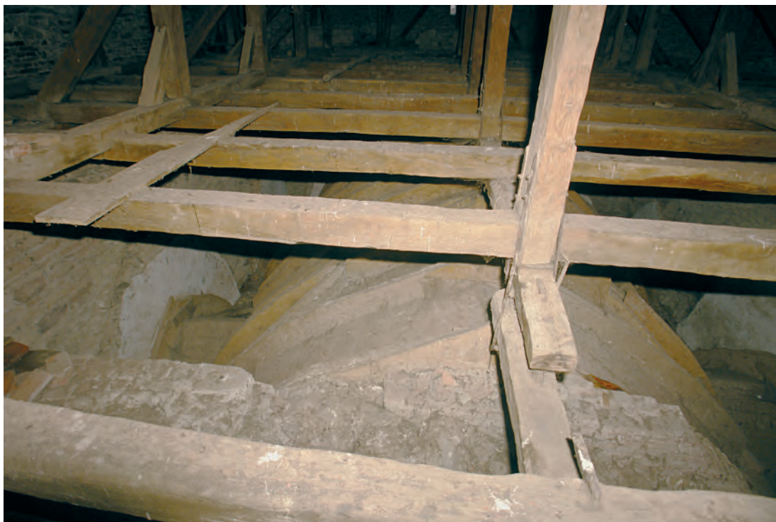
Fig. 178. Soarș. În prim plan zidul de deasupra arcului triumfal. Extradosul de lemn al altarului și în stanga arhivolta gotică.
